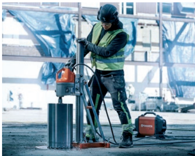
Husqvarna krunska bušilica sa stalkom – za bušenje otvora za vodovod i odvodnju, klimu, električne instalacije
