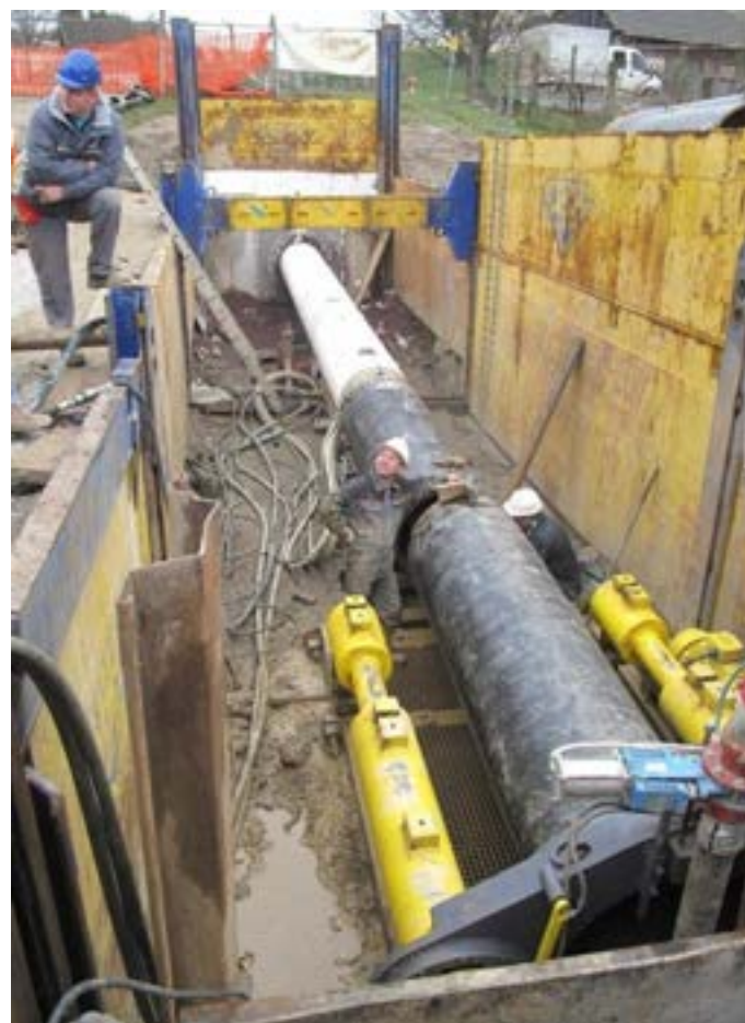
Prikaz potiskanja plinovodne cijevi
